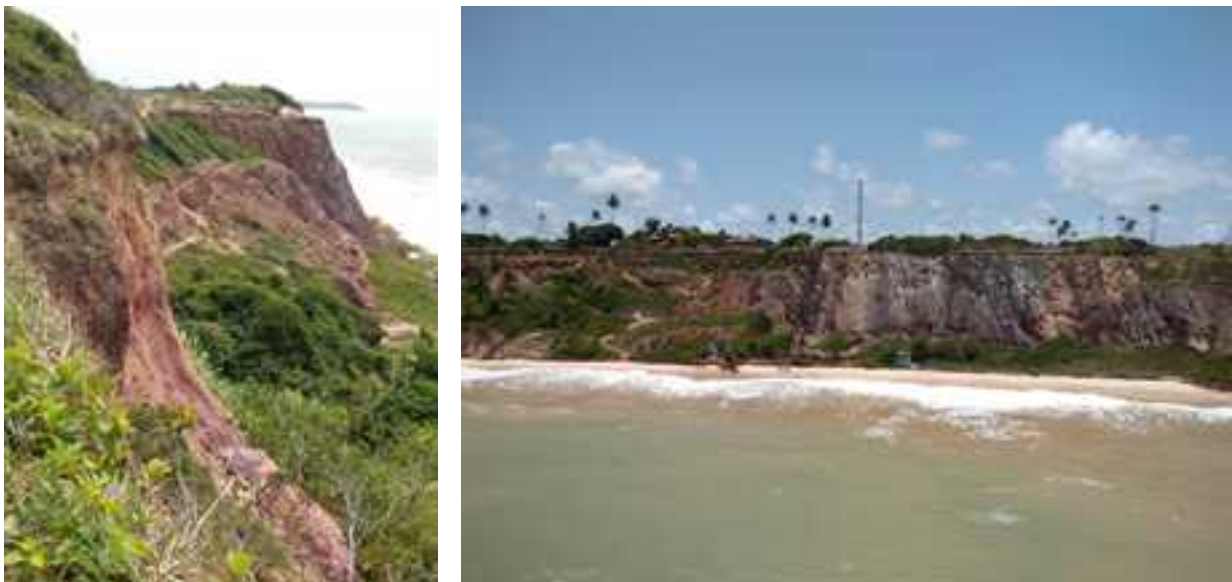
Figura 7. Falésias instáveis definidas pela Formação Barreiras (Fonte: autor, durante trabalho de campo pedestre e sobrevoo).
