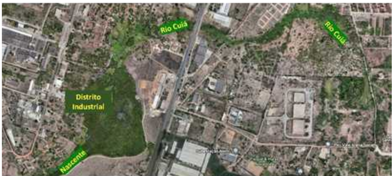
Figura 23. Nascente e trecho inicial do rio Cuiá (Fonte: Google Earth).
