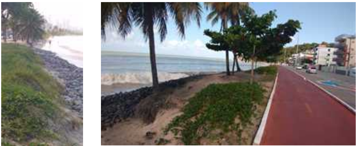
Figura 9. Terraços marinhos Tambaú, totalmente destruídos por estrutura urbana e muitos alvos de erosão e tentativa de contenção (Fonte: autor, atividade pedestre).
