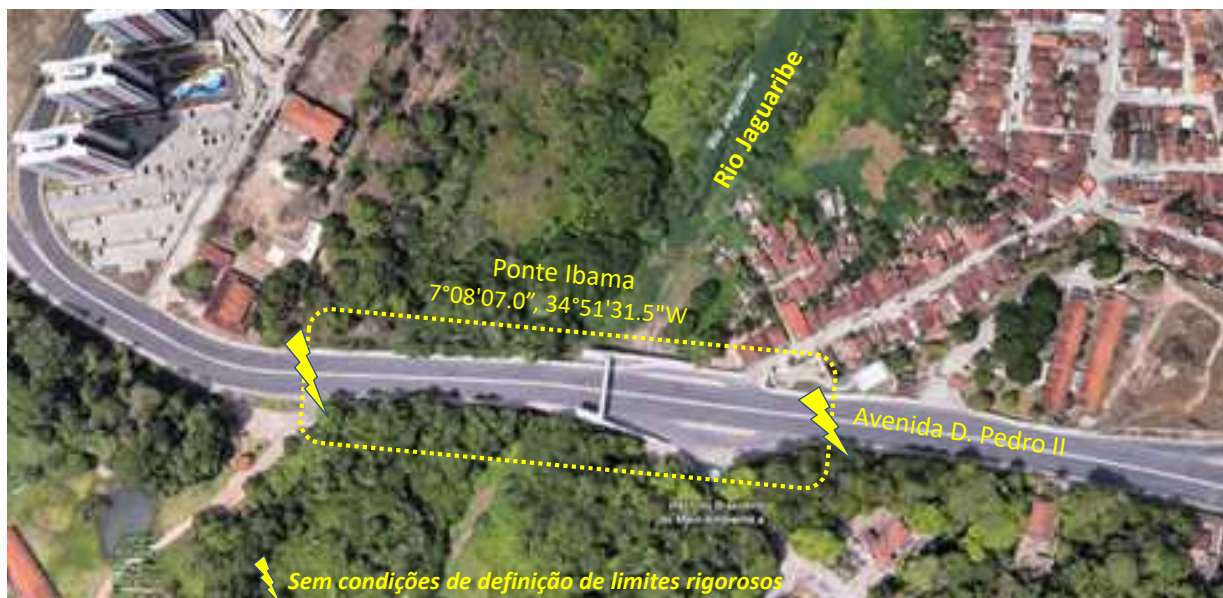
Figura 68. Área PB_JOAOPEs_ARA_04_CON (Fonte: organização do autor sobre base do Google Earth).
