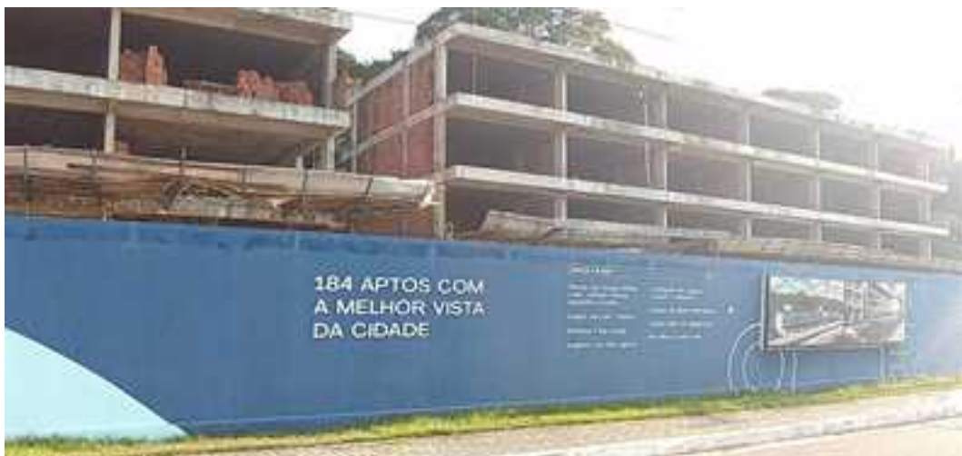
Figura 136. Hotel em construção (Fonte: autor).
