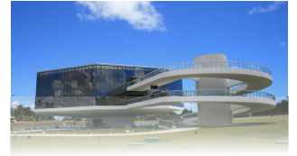
ESTAÇÃO CABO BRANCO
